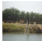
Photo 3 : Station de pompage d'eau pour le périmètre irrigué (2245 ha) aménagé dans le cadre du Millenium Challenge Account (MCA) ( Larech N KABORE, 08-12-2016 )
