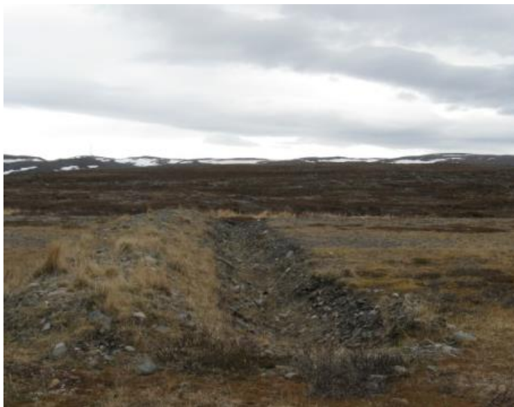
Grøfting av flystripa.
